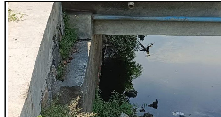
KONDISI KEPALA JEMBATAN
