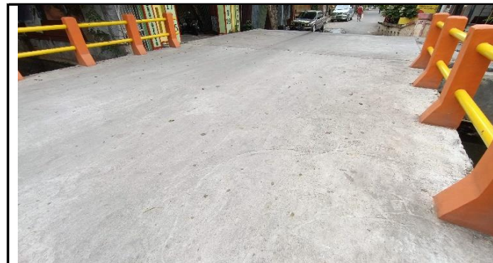
KONDISI LANTAI JEMBATAN
