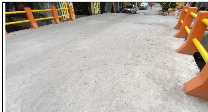
KONDISI LANTAI JEMBATAN
