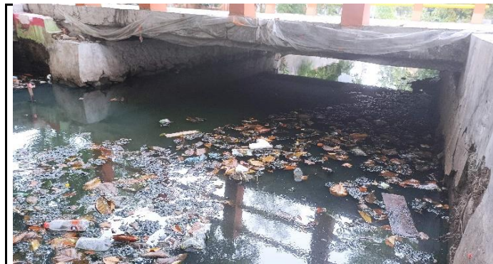
KONDISI BANGUNAN BAWAH
