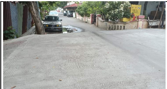
KONDISI JALAN PENDEKAT
