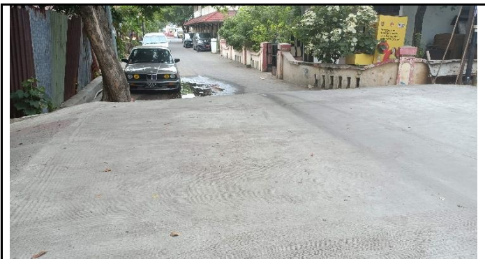
KONDISI JALAN PENDEKAT
