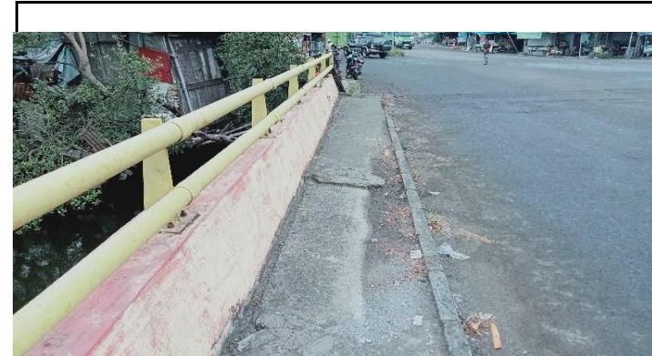
KONDI SANDARAN DAN TROTOAR
