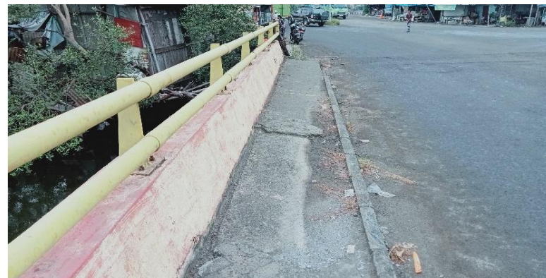
KONDI SANDARAN DAN TROTOAR
