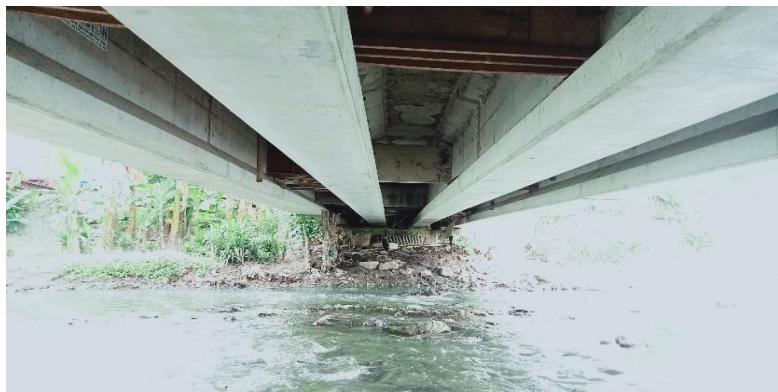
KONDISI BANGUNAN BAWAH
