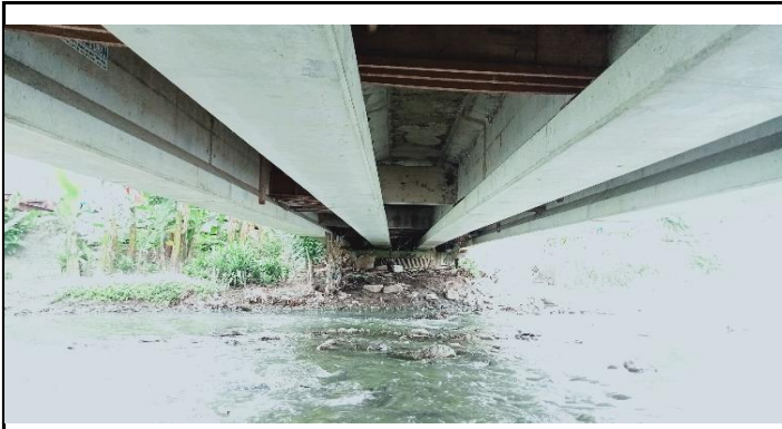
KONDISI BANGUNAN BAWAH
