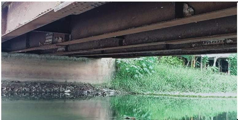
KONDISI BANGUNAN BAWAH
