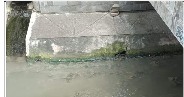
KONDISI KEPALA JEMBATAN
