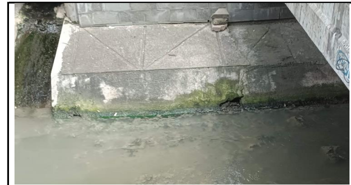
KONDISI KEPALA JEMBATAN
