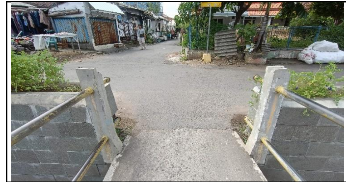
KONDISI JALAN PENDEKAT
