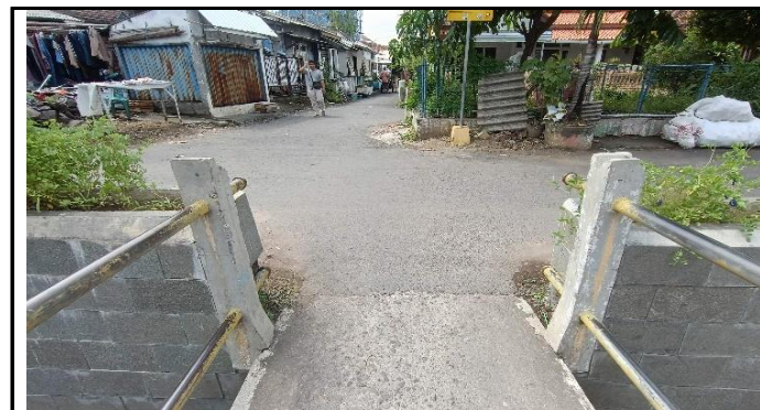
KONDISI JALAN PENDEKAT
