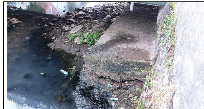
BANGUNAN PERKUATAN BANGUNAN BAWAH TERGERUS
