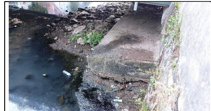
BANGUNAN PERKUATAN BANGUNAN BAWAH TERGERUS
