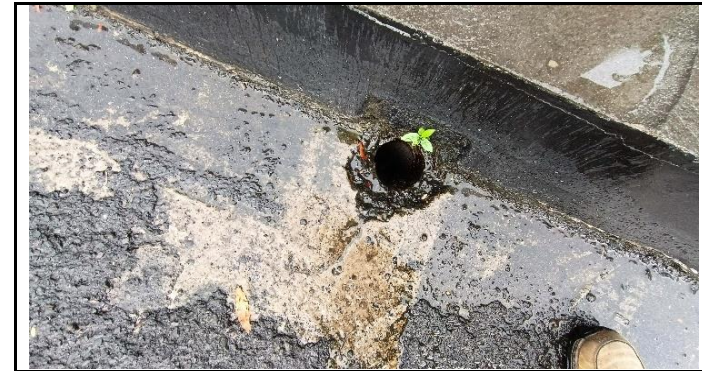
KONDISI DRAINASE LANTAI JEMBATAN
