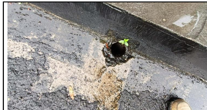
KONDISI DRAINASE LANTAI JEMBATAN
