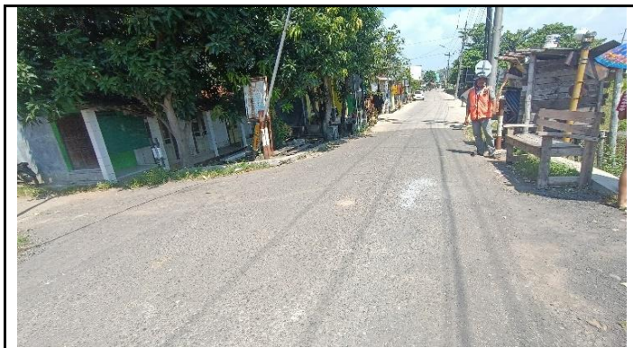
KONDISI JALAN PENDEKAT
