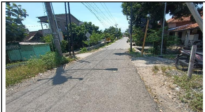
KONDISI JALAN PENDEKAT
