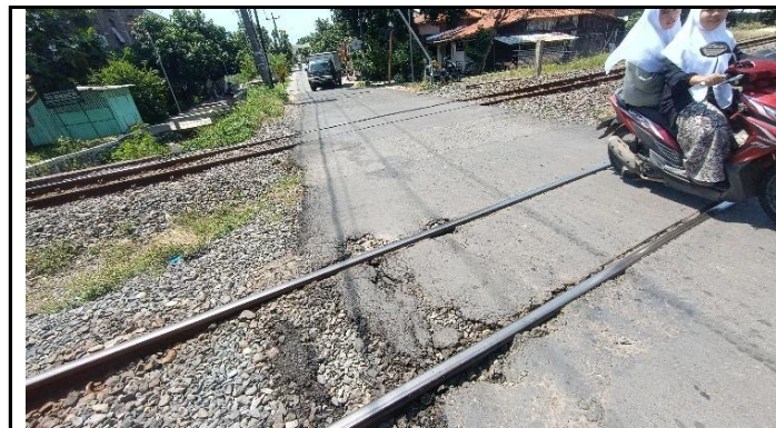
KONDISI LAPISAN PERMUKAAN LANTAI
