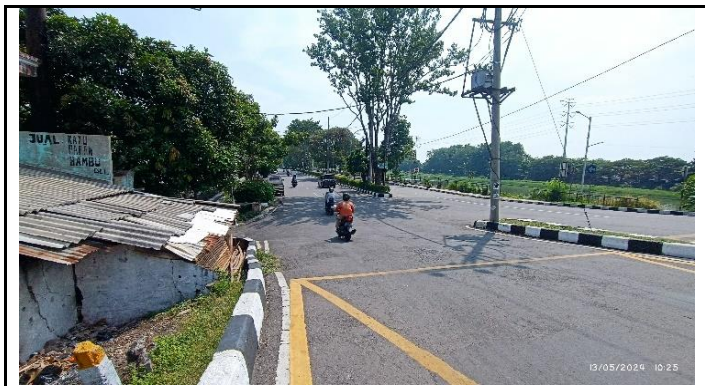
KONDISI JALAN PENDEKAT
