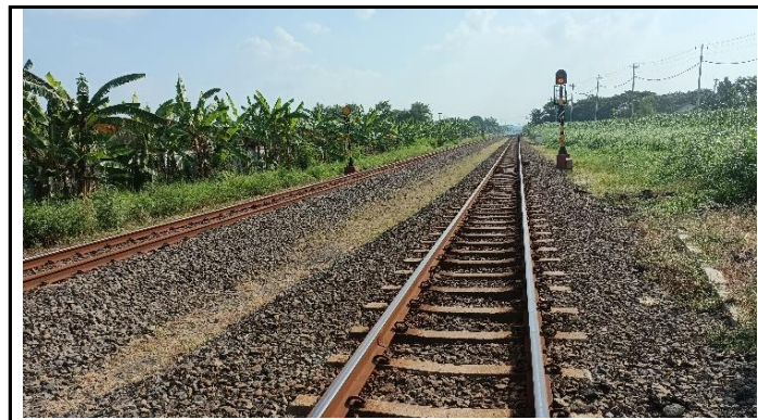
KONDISI REL KERETA API
