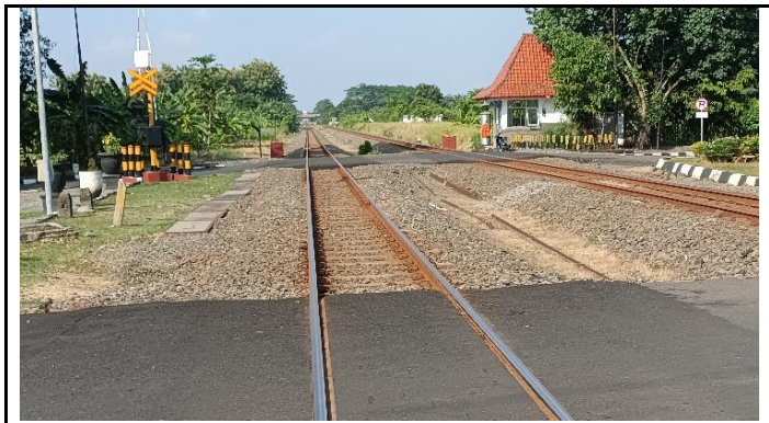
KONDISI REL KERETA API
