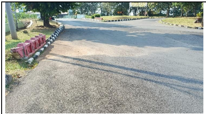
KONDISI JALAN PENDEKAT
