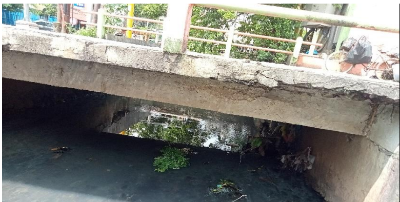
KONDISI BANGUNAN BAWAH
