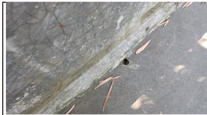
KONDISI PIPA CUCURAN AIR
