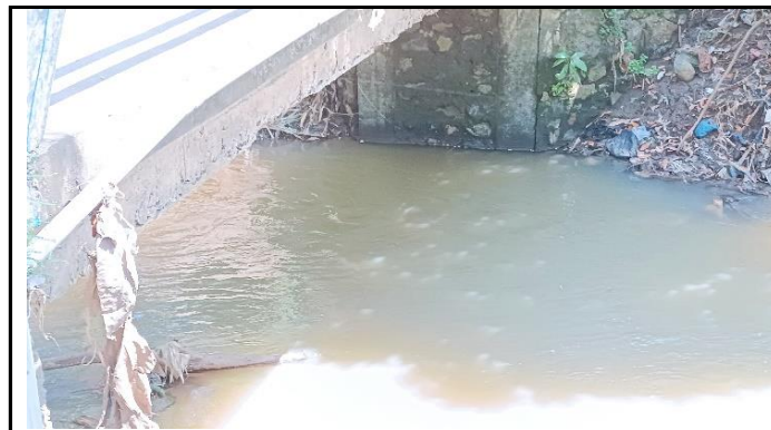
KONDISI BANGUNAN BAWAH
