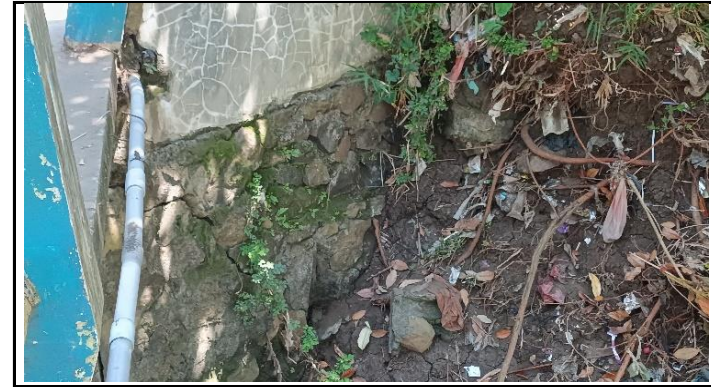
KONDISI TEMBOK SAYAP (DINDING PENAHAN TANAH)
