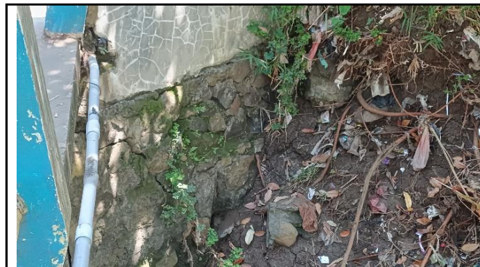
KONDISI TEMBOK SAYAP (DINDING PENAHAN TANAH)
