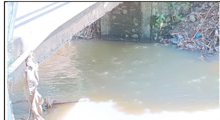
KONDISI BANGUNAN BAWAH
