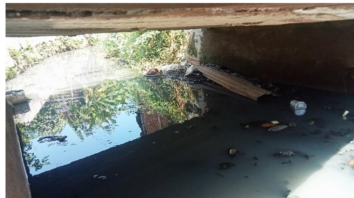
KONDISI BANGUNAN BAWAH
