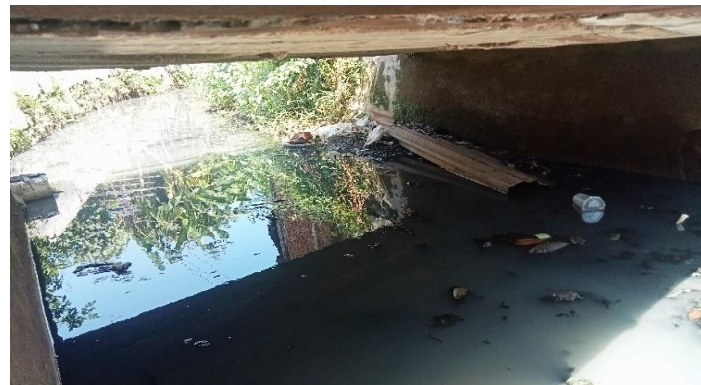
KONDISI BANGUNAN BAWAH
