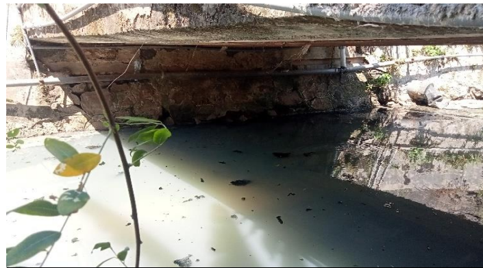
KONDISI BANGUNAN BAWAH
