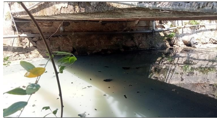
KONDISI BANGUNAN BAWAH
