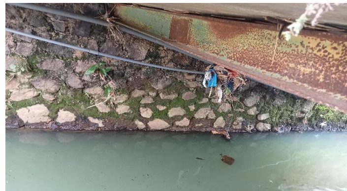
KONDISI BANGUNAN BAWAH
