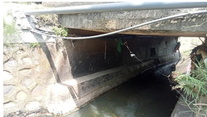
KONDISI BANGUNAN BAWAH
