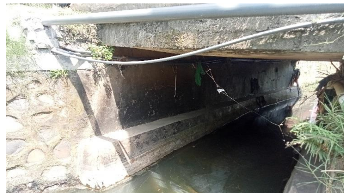
KONDISI BANGUNAN BAWAH
