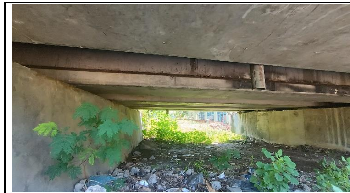
KONDISI BANGUNAN BAWAH
