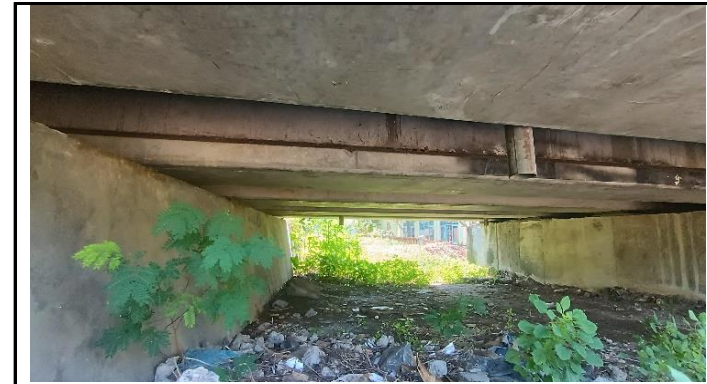
KONDISI BANGUNAN BAWAH
