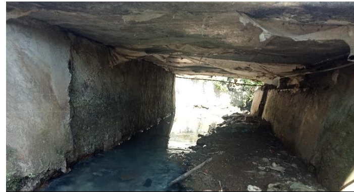
KONDISI BANGUNAN BAWAH
