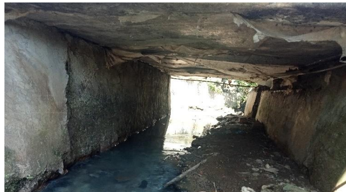
KONDISI BANGUNAN BAWAH
