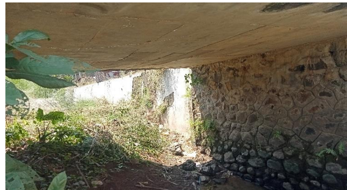
KONDISI BANGUNAN BAWAH
