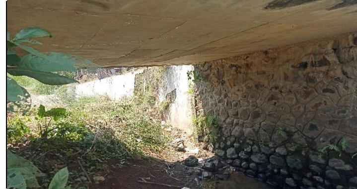
KONDISI BANGUNAN BAWAH
