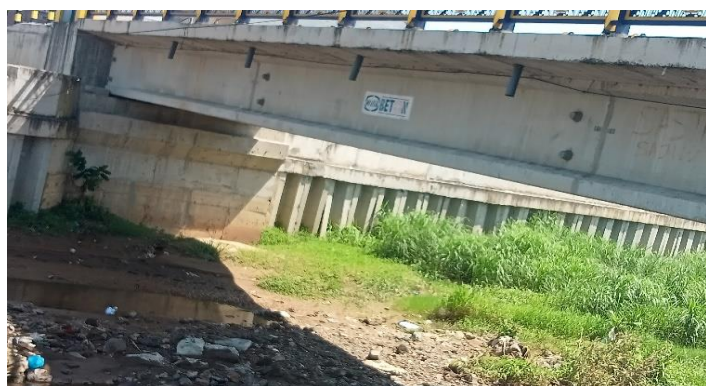
KONDISI BANGUNAN BAWAH
