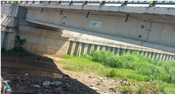
KONDISI BANGUNAN BAWAH
