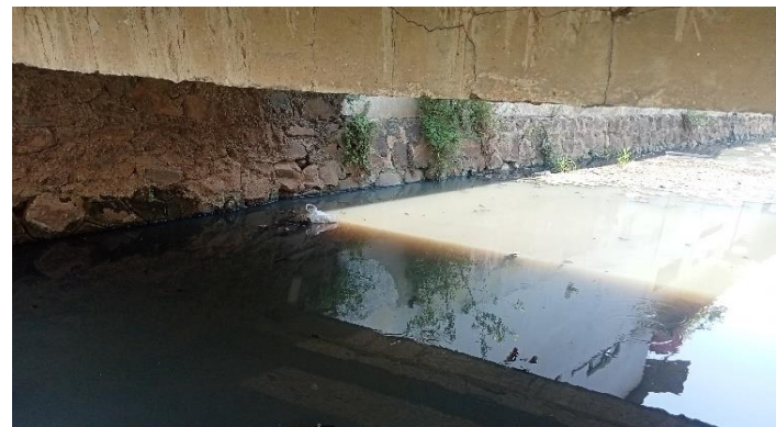
KONDISI BANGUNAN BAWAH
