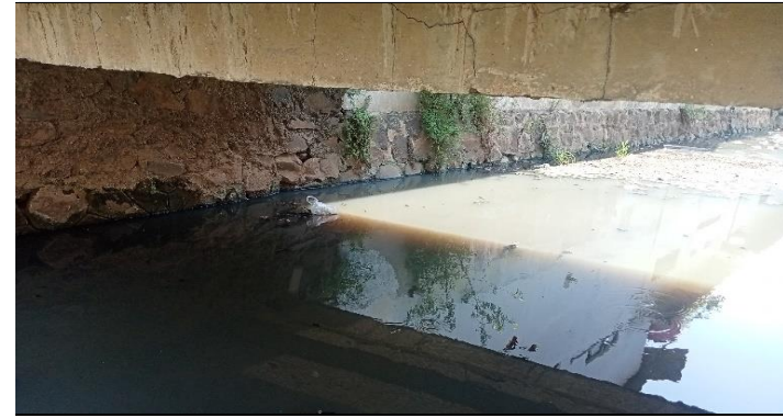
KONDISI BANGUNAN BAWAH
