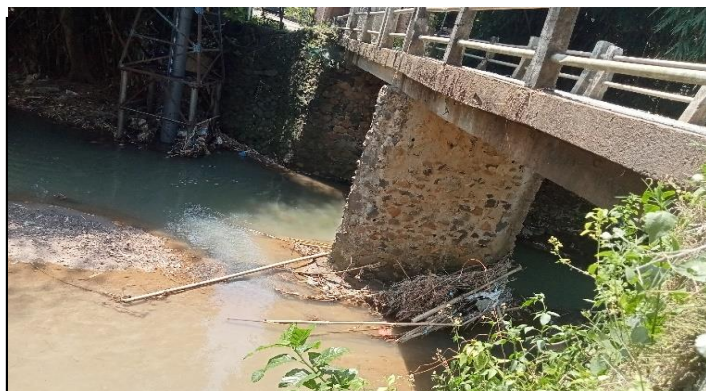
KONDISI BANGUNAN BAWAH
