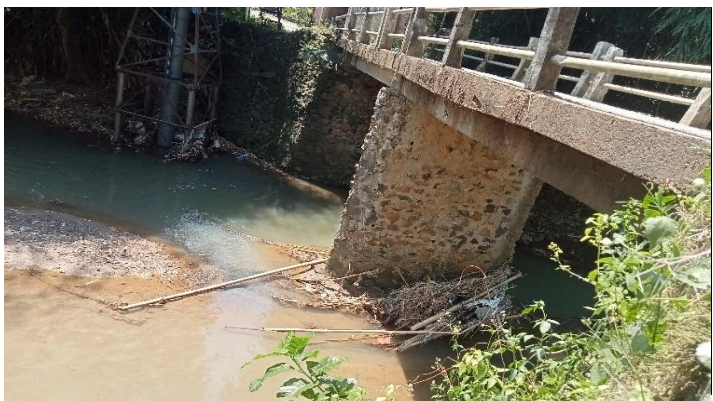
KONDISI BANGUNAN BAWAH
