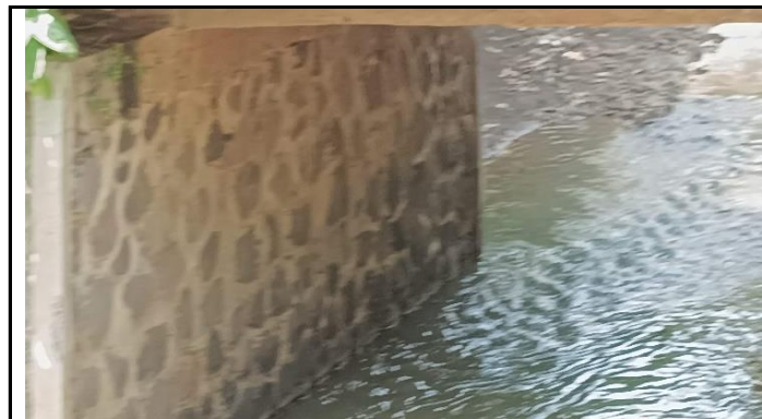
KONDISI KEPALA JEMBATAN
