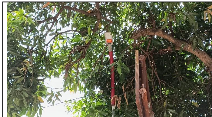
LAMPU PENERANGAN JEMBATAN
