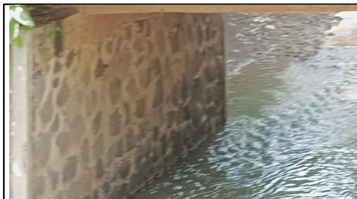
KONDISI KEPALA JEMBATAN
