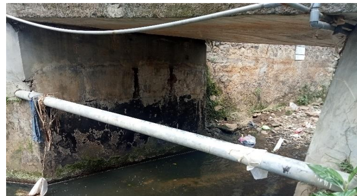
KONDISI BANGUNAN BAWAH
