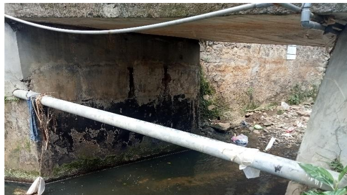
KONDISI BANGUNAN BAWAH
