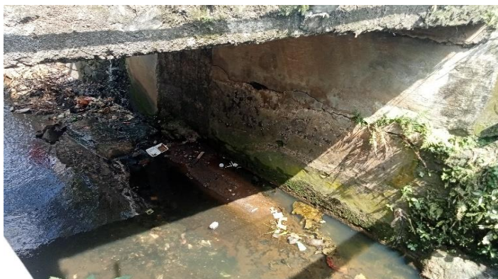
KONDISI BANGUNAN BAWAH
