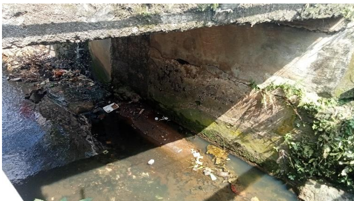
KONDISI BANGUNAN BAWAH
