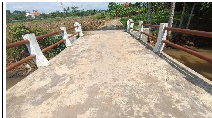
KONDISI LAPISAN PERMUKAAN LANTAI DAN SANDARAN
