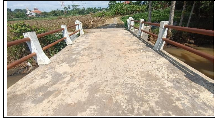
KONDISI LAPISAN PERMUKAAN LANTAI DAN SANDARAN
