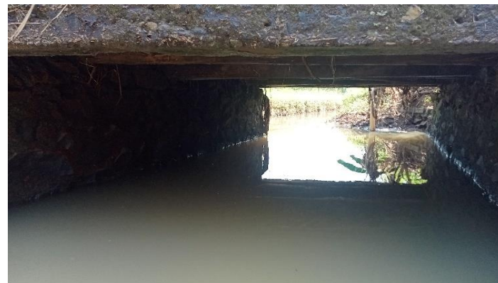
KONDISI BANGUNAN BAWAH
