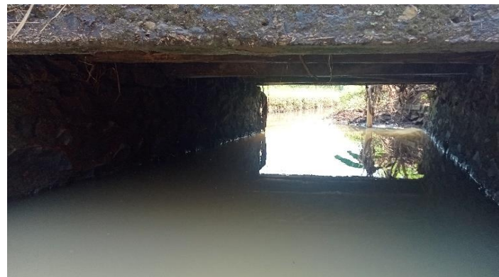
KONDISI BANGUNAN BAWAH
