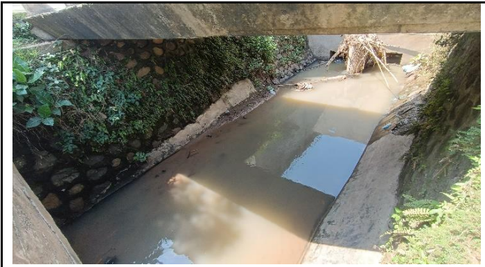
KONDISI BANGUNAN BAWAH
