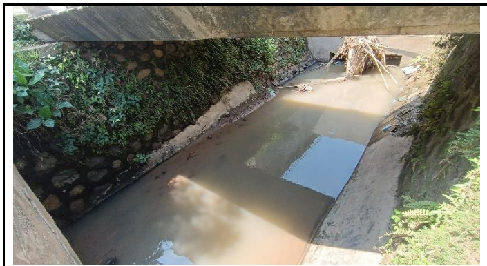
KONDISI BANGUNAN BAWAH
