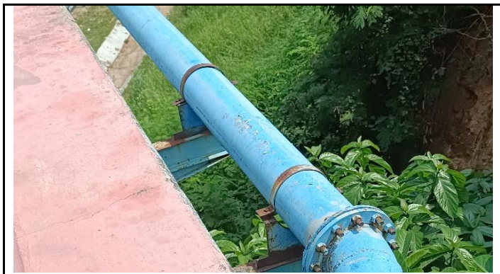
KONDISI PIPA UTILITAS
