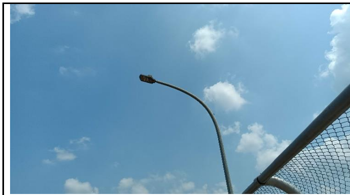
KONDISI LAMPU PENERANGAN JEMBATAN
