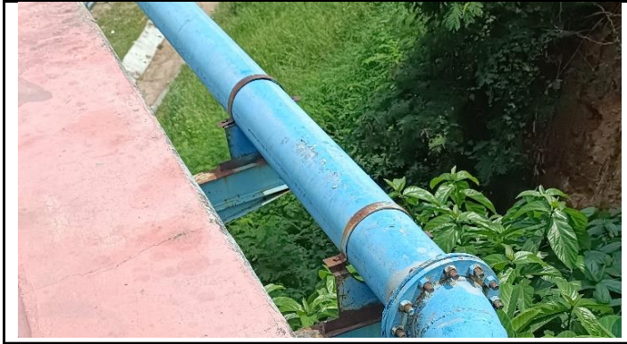
KONDISI PIPA UTILITAS
