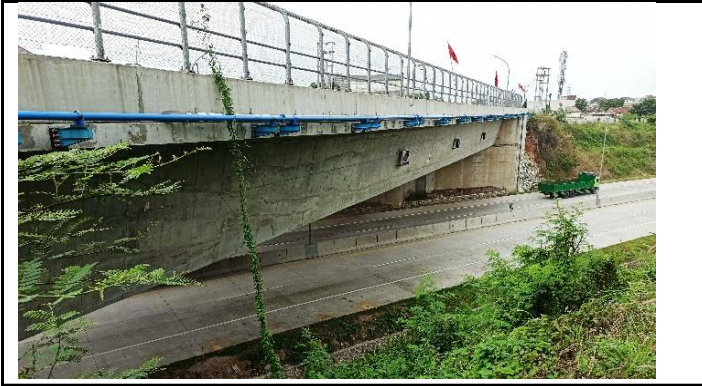
KONDISI BANGUNAN BAWAH
