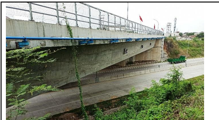
KONDISI BANGUNAN BAWAH
