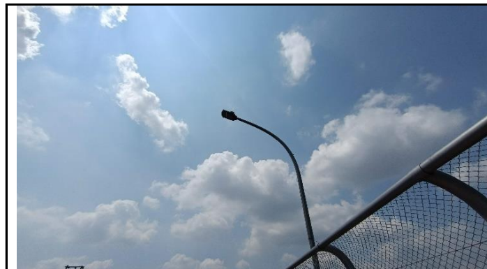
LAMPU PENERANGAN JALAN
