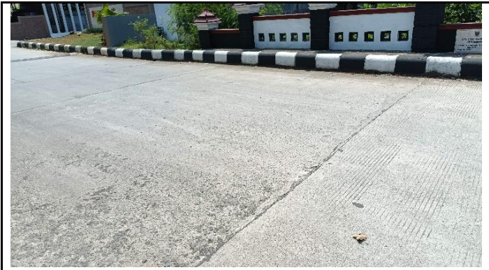
KONDISI LANTAI JEMBATAN
