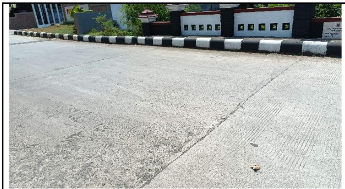
KONDISI LANTAI JEMBATAN
