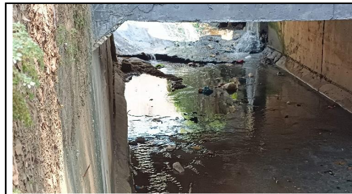
KONDISI BANGUNAN BAWAH
