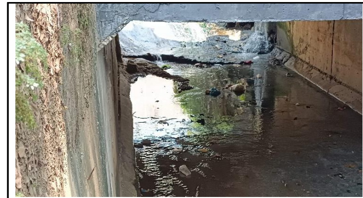
KONDISI BANGUNAN BAWAH
