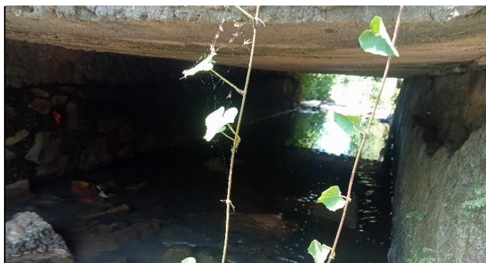
KONDISI BANGUNAN BAWAH
