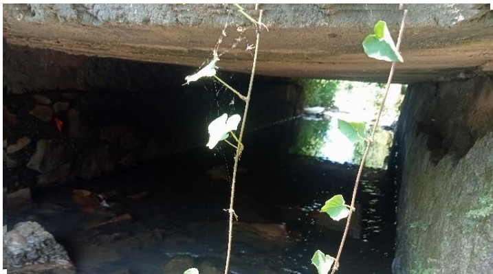
KONDISI BANGUNAN BAWAH
