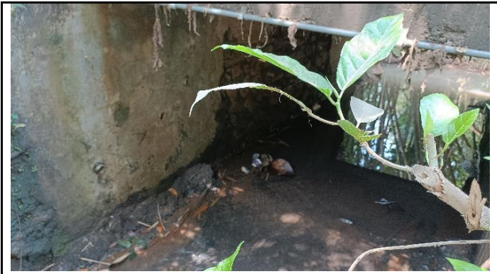
KONDISI KEPALA JEMBATAN
