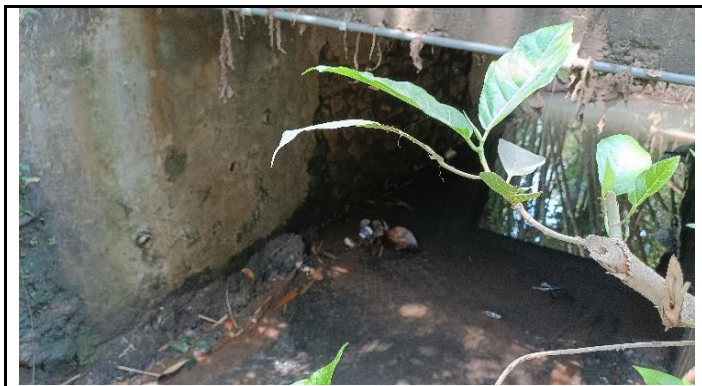
KONDISI KEPALA JEMBATAN
