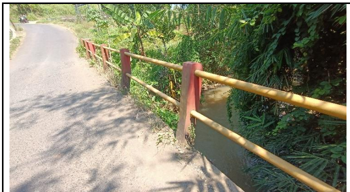
KONDISI SANDARAN JEMBATAN
