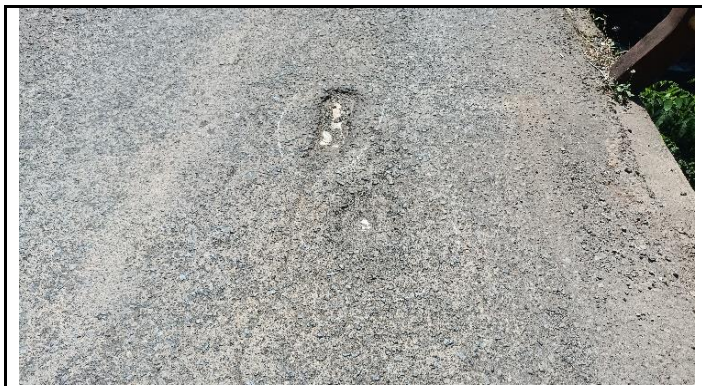
LAPISAN PERMUKAAN LANTAI BERLUBANG
