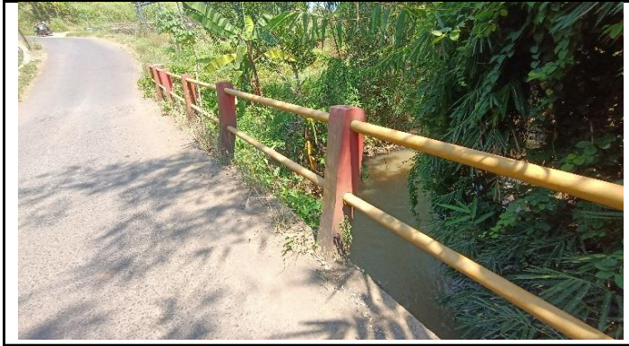
KONDISI SANDARAN JEMBATAN
