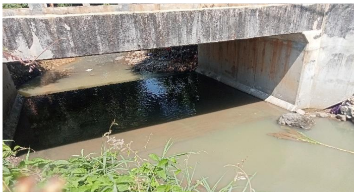
KONDISI BANGUNAN BAWAH
