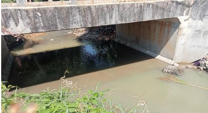
KONDISI BANGUNAN BAWAH
