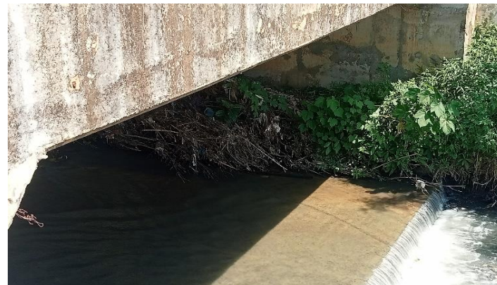
KONDISI BANGUNAN BAWAH
