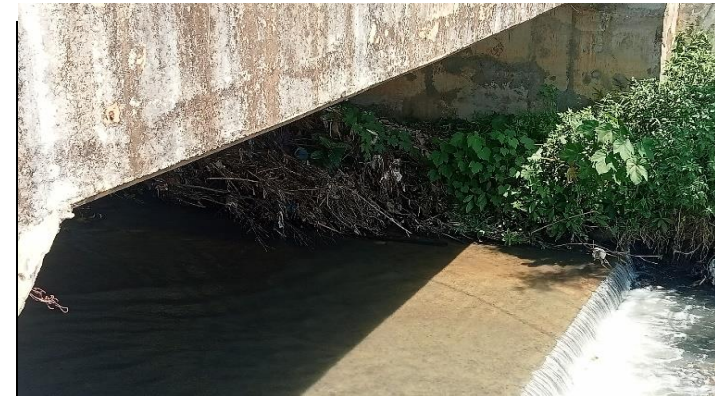
KONDISI BANGUNAN BAWAH
