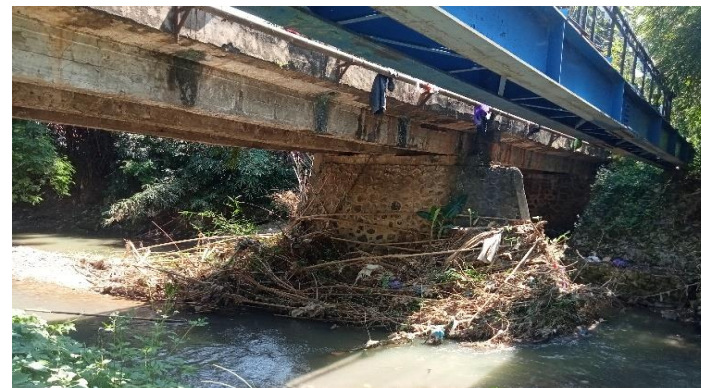
KONDISI BANGUNAN BAWAH
