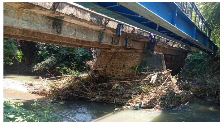
KONDISI BANGUNAN BAWAH
