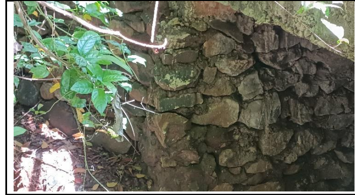
KONDISI KEPALA JEMBATAN
