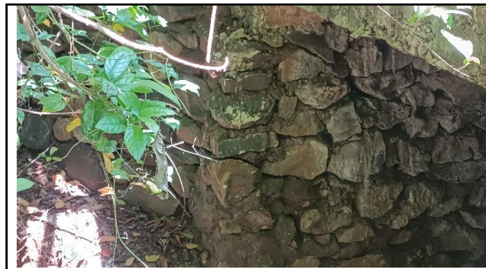
KONDISI KEPALA JEMBATAN
