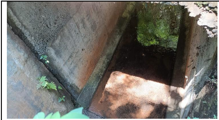
KONDISI BANGUNAN BAWAH
