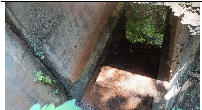
KONDISI BANGUNAN BAWAH
