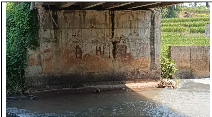
KONDISI KEPALA JEMBATAN
