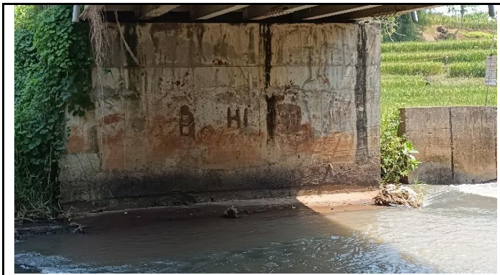
KONDISI KEPALA JEMBATAN
