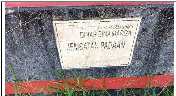
PAPAN NAMA JEMBATAN
