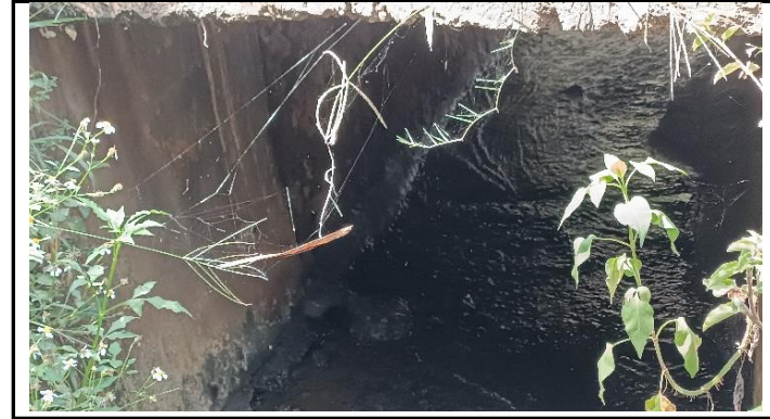
KONDISI BANGUNAN BAWAH
