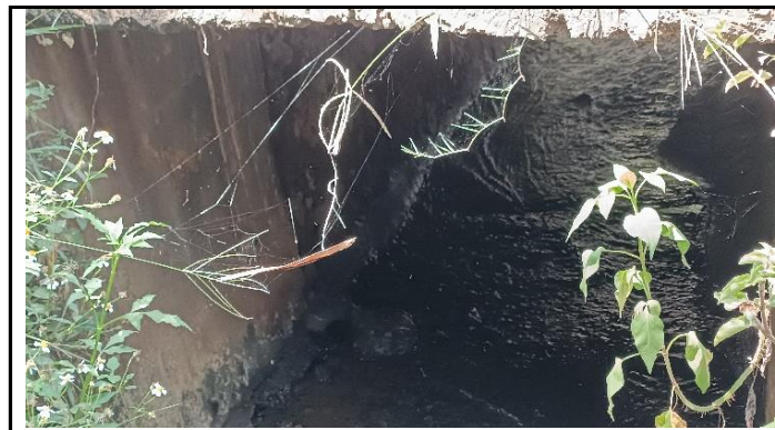
KONDISI BANGUNAN BAWAH
