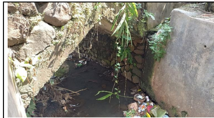
KONDISI BANGUNAN BAWAH
