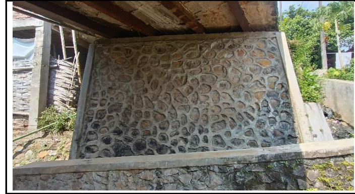
KONDISI KEPALA JEMBATAN
