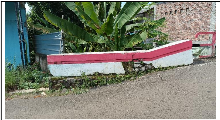
PARAPET RETAK
