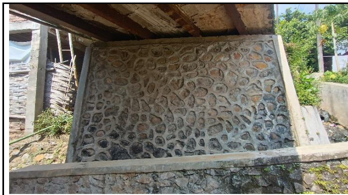
KONDISI KEPALA JEMBATAN
