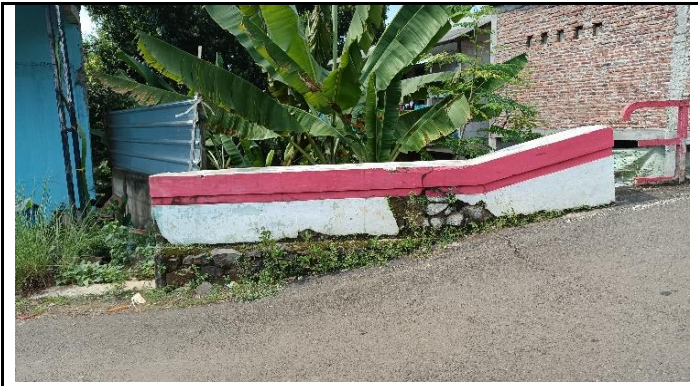
PARAPET RETAK
