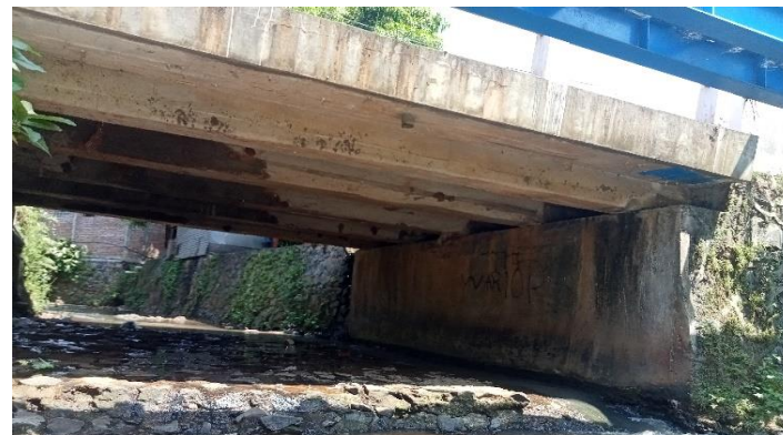
KONDISI BANGUNAN BAWAH
