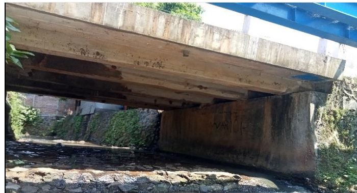
KONDISI BANGUNAN BAWAH
