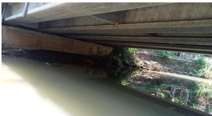
KONDISI BANGUNAN BAWAH
