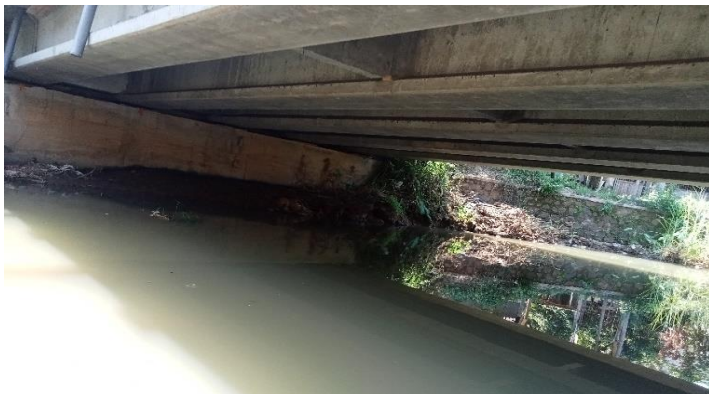
KONDISI BANGUNAN BAWAH
