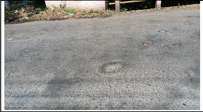
LAPISAN PERMUKAAN LANTAI BERLUBANG
