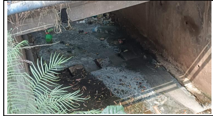
KONDISI BANGUNAN BAWAH
