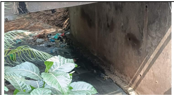
KONDISI BANGUNAN BAWAH
