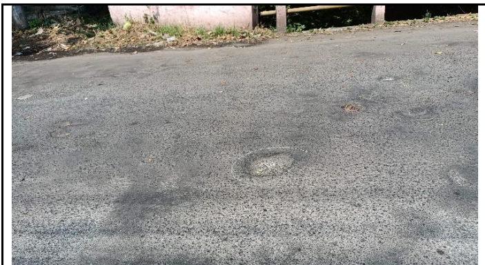
LAPISAN PERMUKAAN LANTAI BERLUBANG
