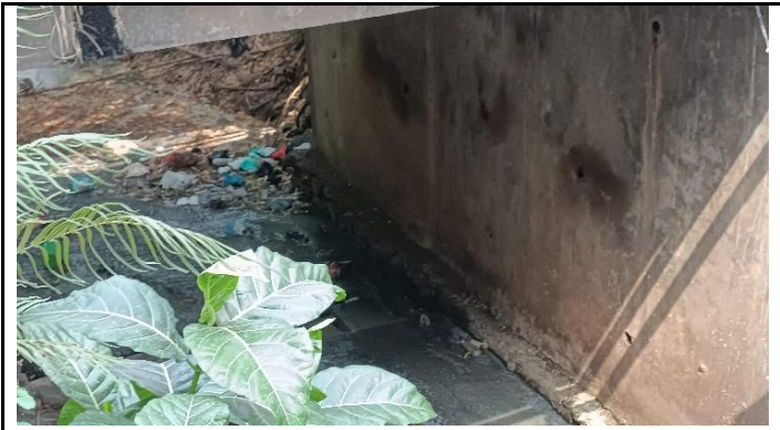
KONDISI BANGUNAN BAWAH
