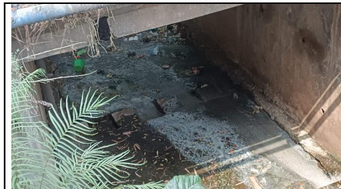
KONDISI BANGUNAN BAWAH
