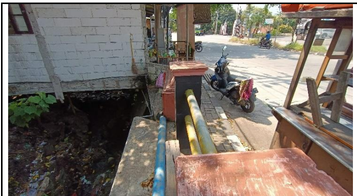
KONDISI PIPA UTILITAS
