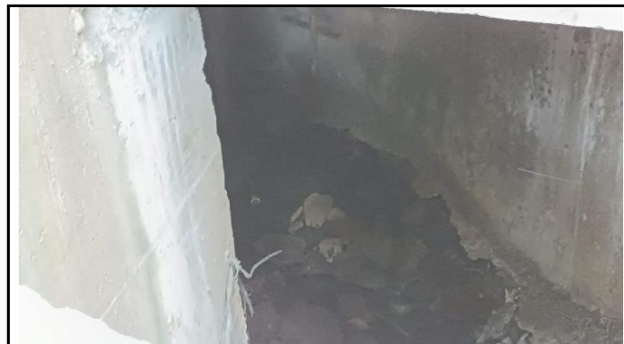
KONDISI BANGUNAN BAWAH
