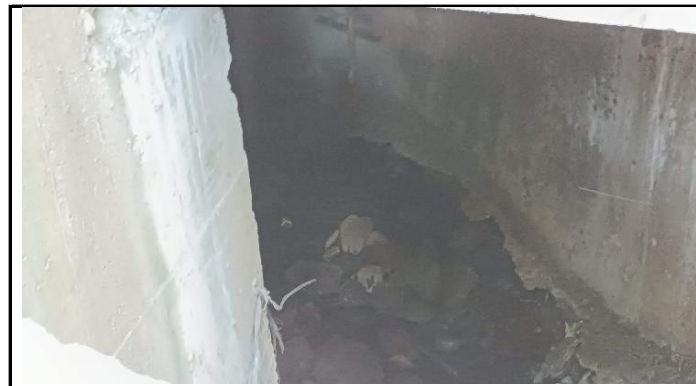
KONDISI BANGUNAN BAWAH
