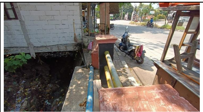
KONDISI PIPA UTILITAS
